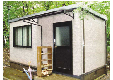
学校施設 (部室)
